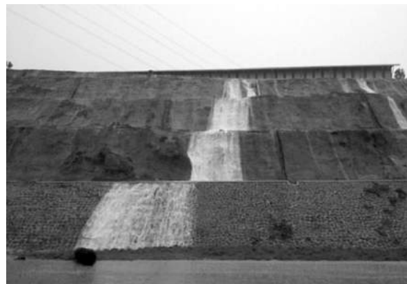
Gambar 4. Limpasan Pada Lereng Sebelum Terjadi Longsor (Jasa Marga, 2015)
