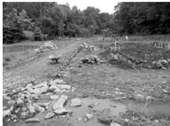
Gambar 7. Pembangunan Tahap Cut and Clearing
